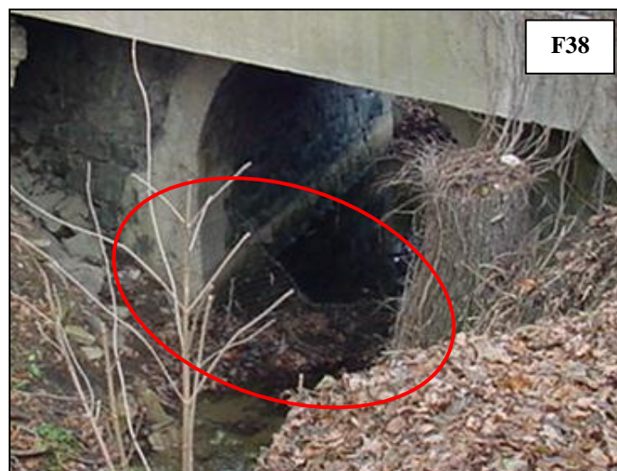
Detailní pohled na zbytky plotového pletiva a usazování plavenin.
