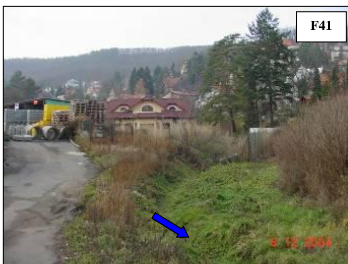
Přehrazení toku pod areálem stavebnin, nebezpečí usazování plavenin a ohrožení objektů v ulici ke Švarcavě a suterénních prostor hotelu.
