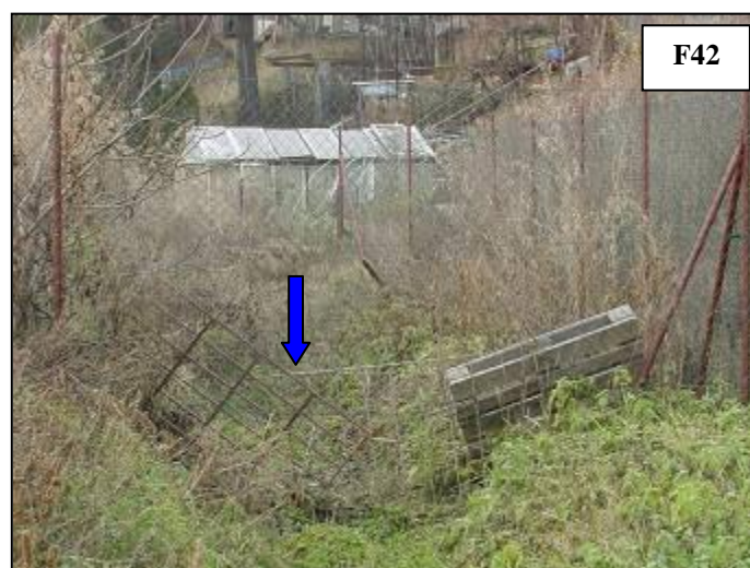
Pohled na přehrazení toku.
