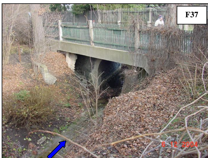
Návodní strana silničního mostu v Poštovní ulici, přes koryto je plotové pletivo, na kterém se zachytávají plaveniny.
