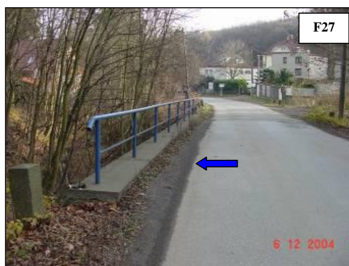
Pohled na silniční most a Karlštejnskou ulici.
