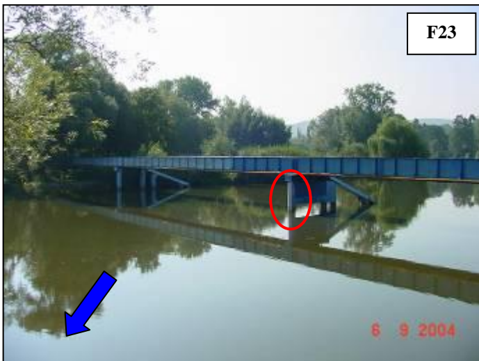
Vodočetná lať je umístěna na prostředním pilíři lávky, na poproudní straně.
