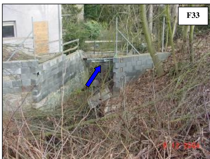
Zúžené místo koryta, nebezpečí uchytování plavenin a ohrožení objektu (Mrázkovi).
