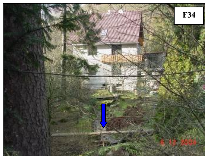
Švarcava pod NM, přes potok lávka pro pěší. Nebezpečí uchytování plavenin a ohrožení objektu (Mrázkovi).
