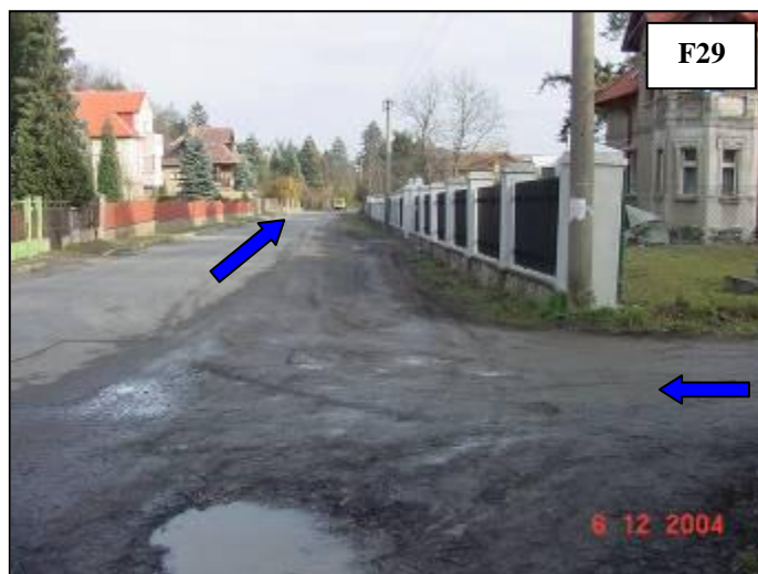
Schéma proudění vody Karlštejnskou ulicí, která ohrožuje objekty na pravé i levé straně ulice (natéká do dvorů a zahrad).
