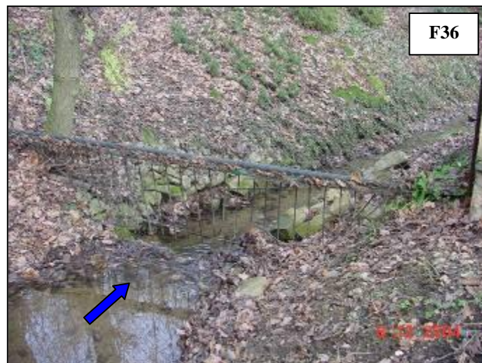
Zahrazení koryta pletivem, nebezpečí usazování plavenin a ohrožení objektů u čp. 277.
